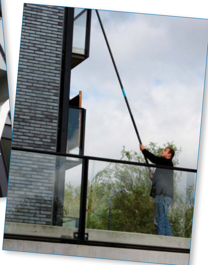
Werken vanaf een plat dak
