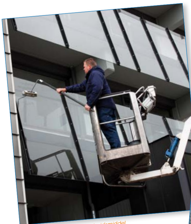
Werken vanaf een mobiel arbeidsmiddel
