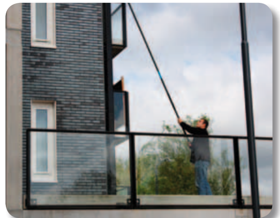
Werken vanaf een plat dak
